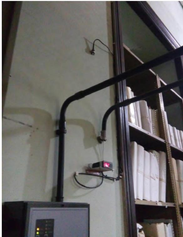
Figura 27 - Local onde está instalado o sensor e equipamento Controlador MT-530 Super do SITRAD. Fonte: Foto da autora.
